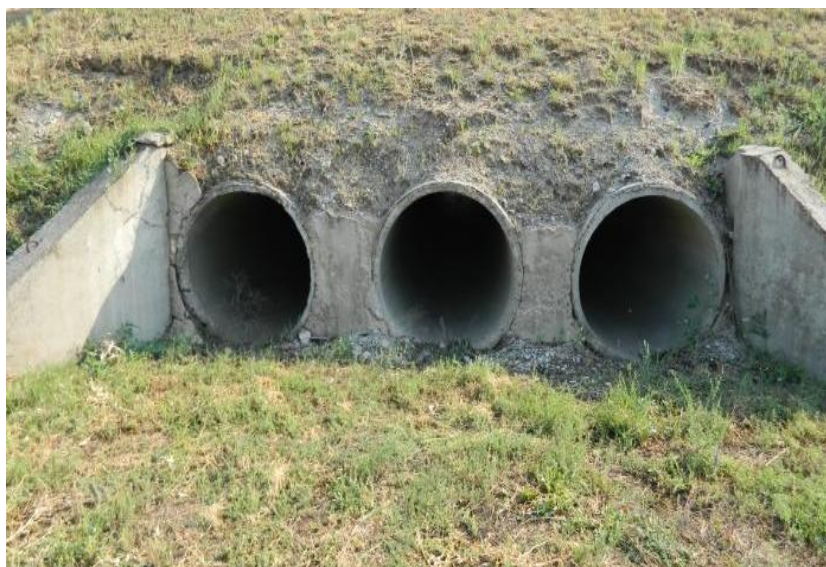
Рис. 3. Многорядное расположение водопропускных труб.
