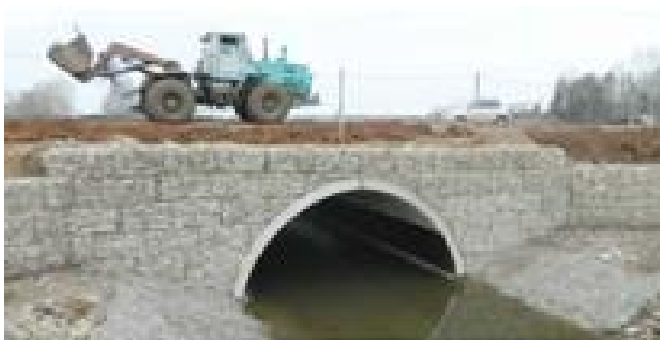
Рис. 7. Водопропускное сооружение арочного типа пролетом 6 м с использованием фундаментной плиты затяжки в Бураевском районе Республики Башкортостан.
