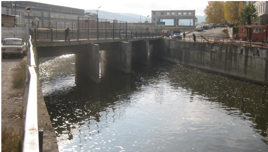
Рис. 2. Вид на нижний бьеф водосброса Усть-Катавского гидроузла.
