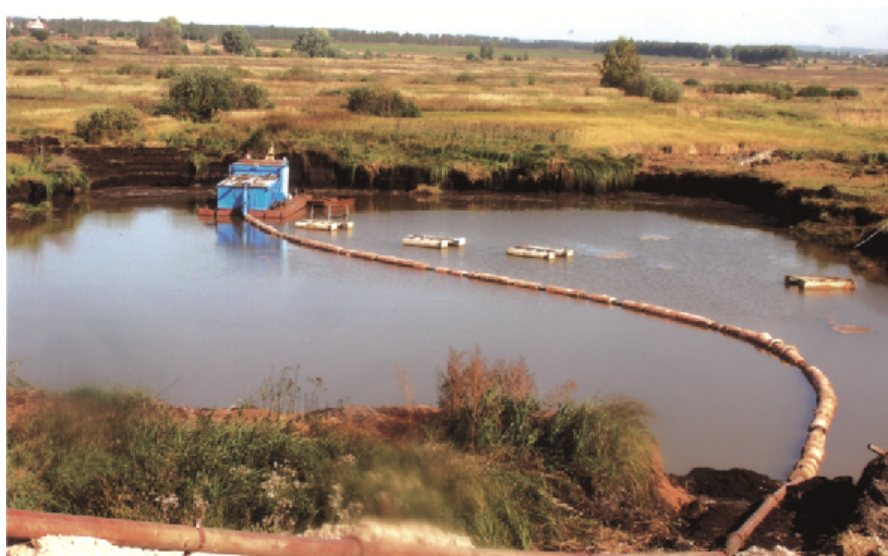
Рис. 4. Строительство хозяйственного водоема.
