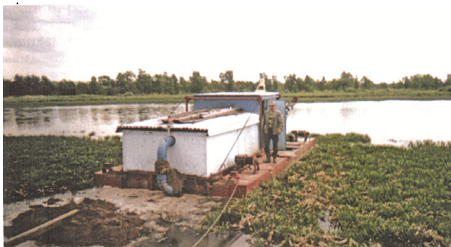
Рис. 3. Расчистка заросшего канала в Курьмской сельхознизине в Нижегородской области.
